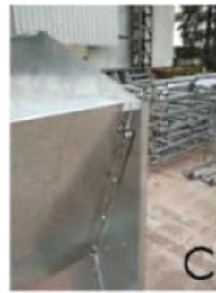
C - Laterales; presentar la pieza con los tornillos hacia afuera. (comenzar a bulonar desde arriba del segundo orificio).
