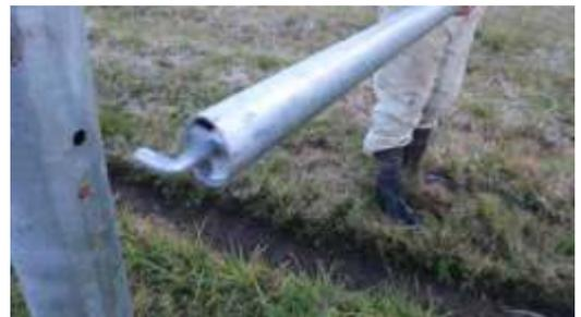
**B.2** - El otro extremo del puntal se calza en el plato de apoyo y este se apoya en el piso. Uno de los extremos del cable de tensión tiene un pequeño gancho con la iniciales CLIPEx marcadas que se calza en la ranura provista en el plato de apoyo.
