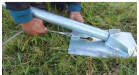
**B.3** - En el extremo opuesto tenemos un cable de acero con un grillete de unión que vamos a pasar por alrededor del poste para de esta manera queden unidos el poste con el plato de apoyo.
