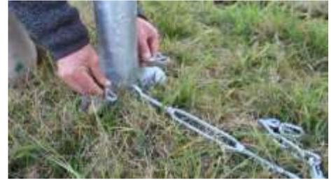
**B.4** - Luego utilizaremos la cadena y el tensor de doble ojo para ajustar lo más posible el cable. Es muy importante que el cable quede bien ajustado y firme. De manera contraria el arranque se moverá cuando estiremos el alambrado.
