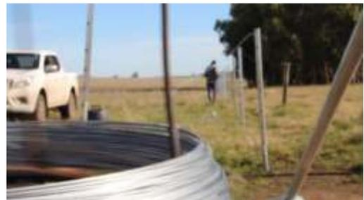
**4.3 Estire los alambres con 180 kg de tensión en los marcos (hilos de arriba y abajo) y 150 kg de tensión en cada uno de los hilos intermedios .**
